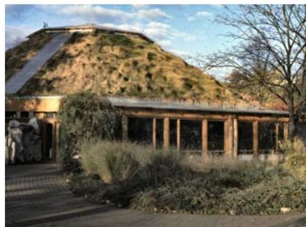
Dachbegrünungen halten viel Regenwasser zurück und führen es dem natürlichen Kreislauf direkt wieder zu. Es fällt weniger Abwasser an, Abfluss-Spitzen werden verringert und die Kanalisation wird entlastet. Kanalquerschnitte und Rückhalteeinrichtungen für Regenwasser können daher kleiner dimensioniert werden.
